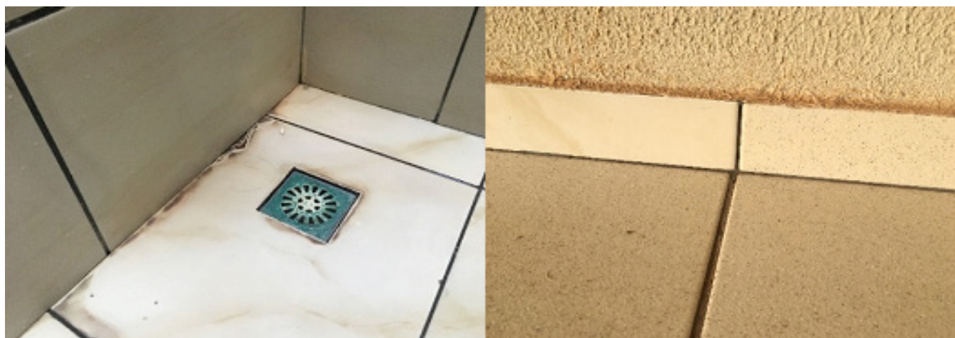
Figura 3 - Umidade e trincas no revestimento cerâmico do banheiro. Existência de dois tipos de revestimento diferente em um único ambiente
