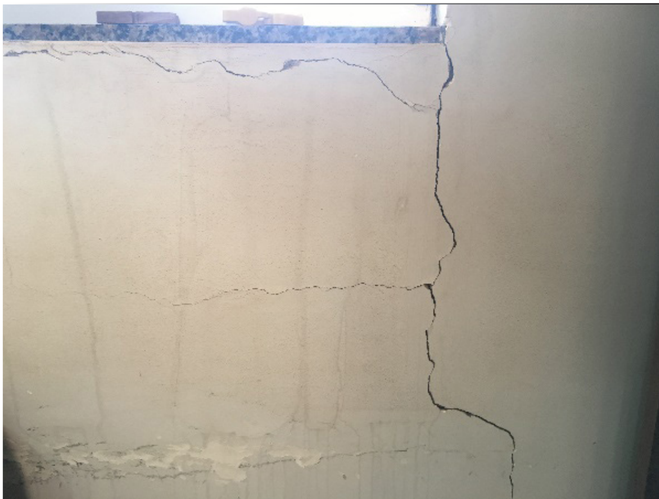
Figura 2 - Trincas na parede do cômodo
