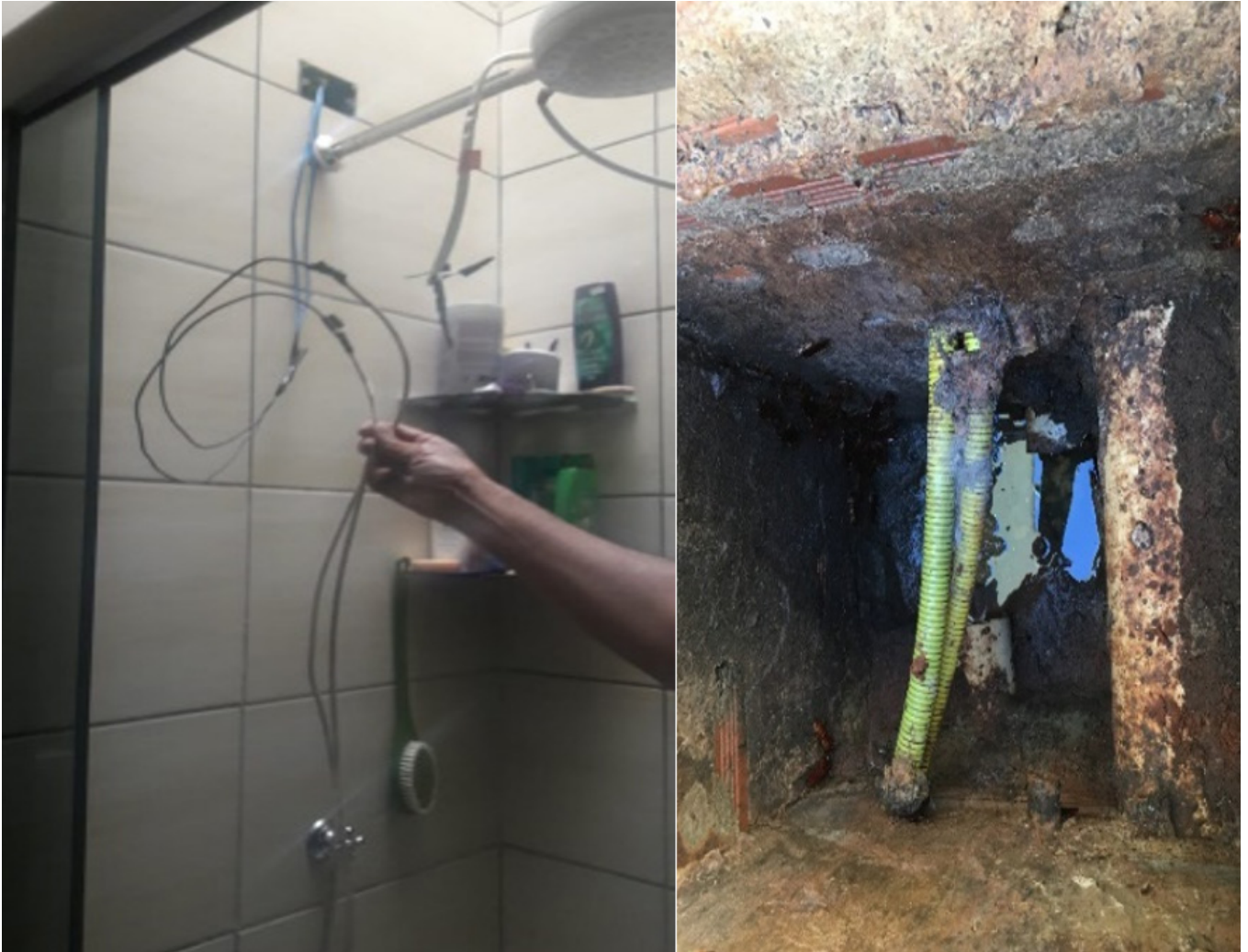
Figura 4 - Fiação inadequada para o uso da instalação. Utilização da mesma passagem da rede de esgoto e instalações elétrica
