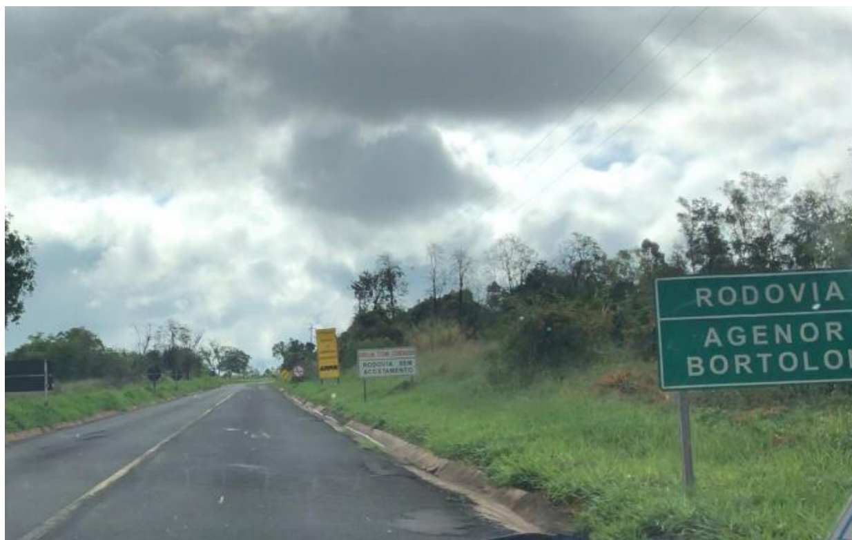
Figura 3 - Indicação de rodovia sem acostamento (Segmento km 1)
