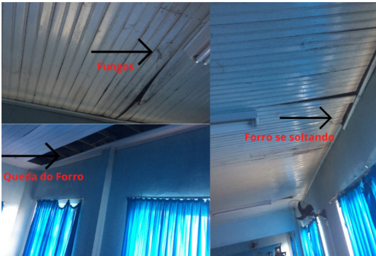
Figura 3 - Forro da academia do ginásio de esportes
