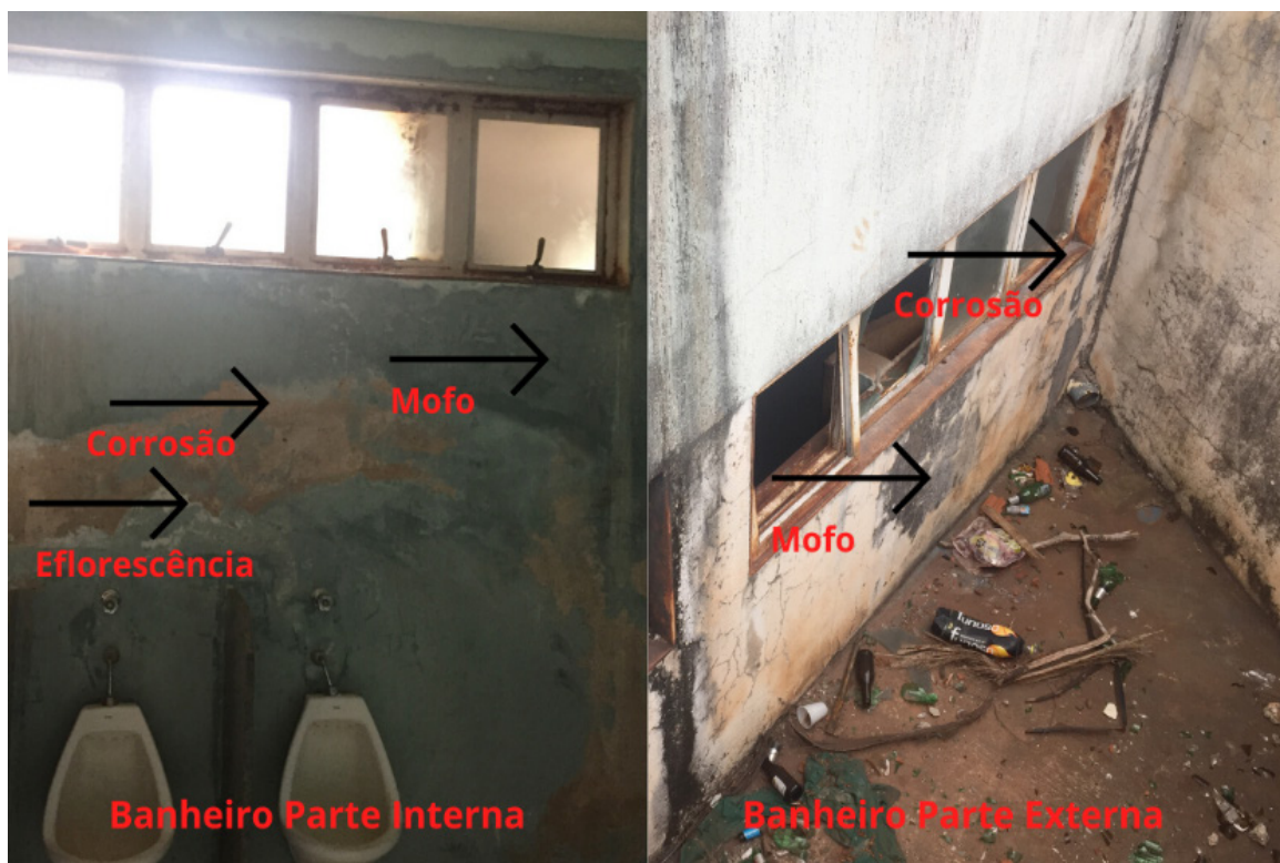
Figura 2 - Banheiro do ginásio de esportes
