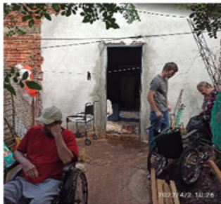
Foto: Acesso ao interior do imóvel sem acessibilidade
