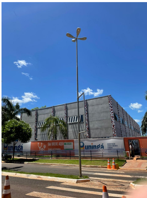
Figura 12: Construção da nova clínica veterinária. Fonte: Elaborado pela CPA, 2024.
