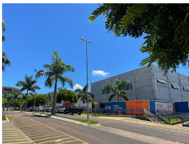
Figura 13: Construção de novo bloco para a EAD e Núcleo de Práticas Jurídicas. Fonte: Elaborado pela CPA, 2024.
